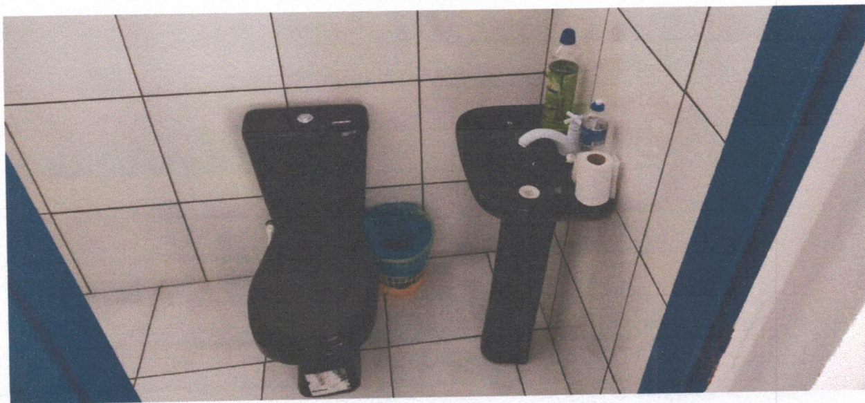
Foto 06 – Interno – W.C Social – Instalações de Água e Esgoto.
