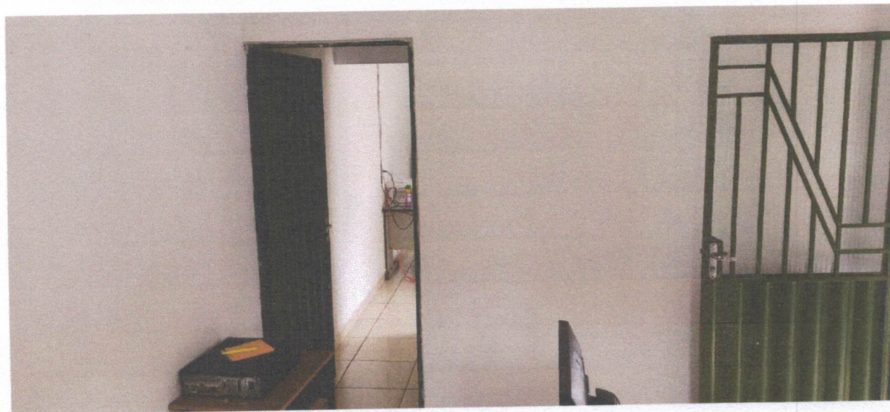
Foto 04 – Interno – Sala de Atendimento - Pintura de Alvenaria e Instalações Elétricas - Esquadrias.
