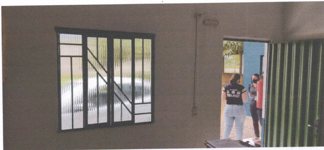
Foto 03 – Interno – Sala de atendimento - Revestimento de Alvenaria / Instalação elétrica - Esquadrias.
