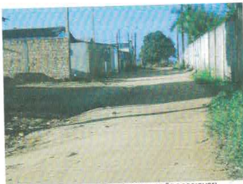
IMAGEM MOSTRA SITUAÇÃO DA VIA(JOÃO RODRIGUES) DATA: 19/03/2014
